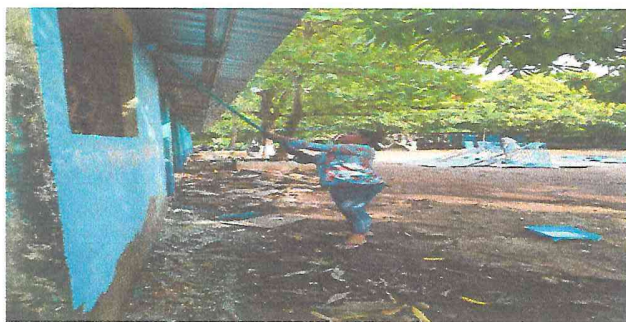
Foto 3, Pintado de muro
