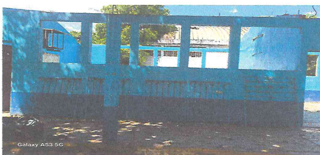
Foto. Lijado y pintado de balcones
