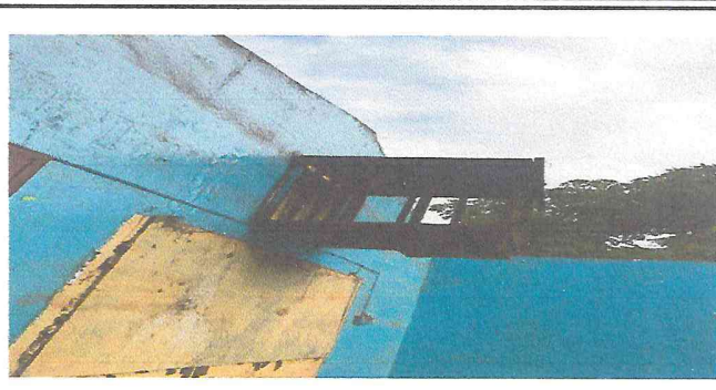
foto.2 Desmantelado de techo
