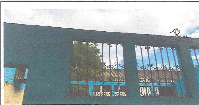
Foto.1 . Mantenimiento a Estructura lijado y pintado
