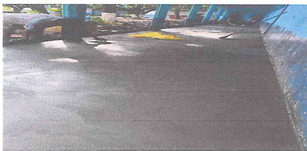
Foto. 5 Aplicacion de piso
